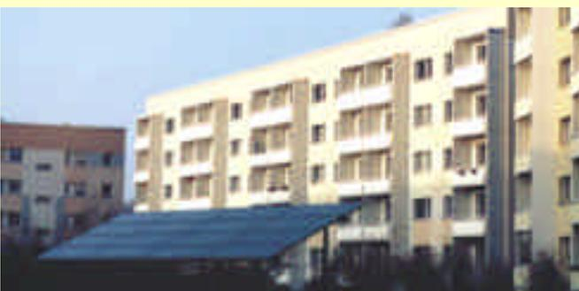
Die Nutzung der natürlichen Sonnenenergie zur Brauchwassererwärmung ist eine Technik, die zu einer deutlichen Verringerung der CO<sub>2</sub>-Emissionen, die bei der Verbrennung von fossilen Energieträgern entstehen, beiträgt. Aus dieser Erwägung heraus, hat die WWV im Sommer dieses Jahres für die Gebäude Hardenbergstraße 5-16 und 39-42 eine thermische Solaranlage installiert.
